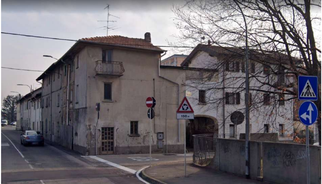
Via Bonacalza – FOTO dalla strada
