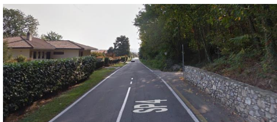
Strada provinciale SP 4 all'incrocio di Via San Martino (verso sud)
