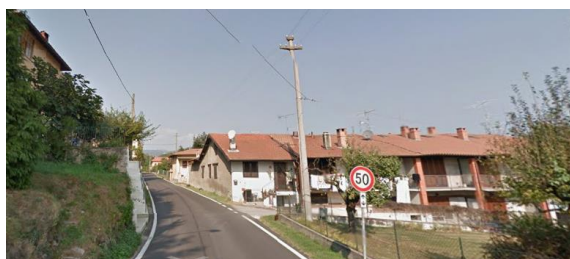
Nodo critico: restringimento della carreggiata lungo la SP 4
