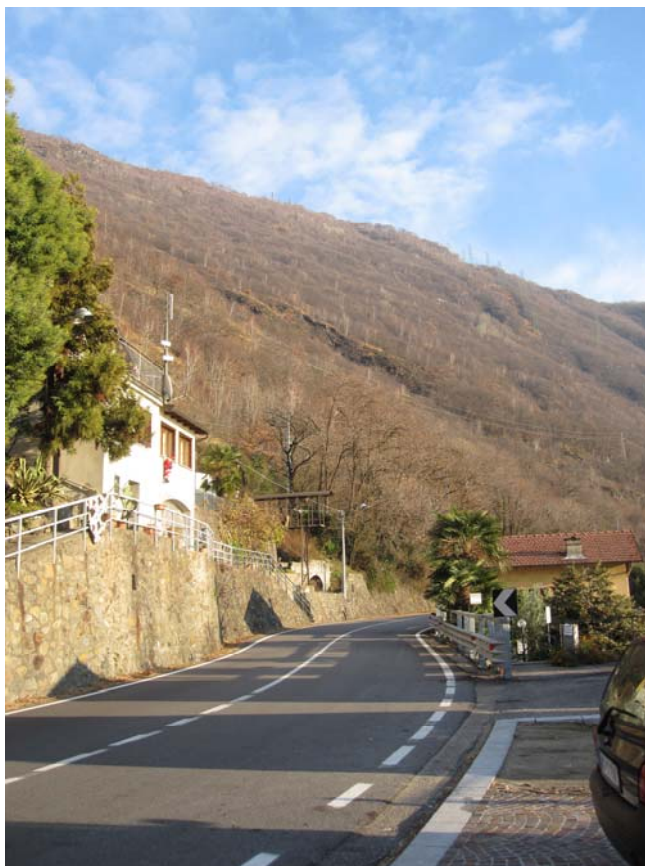
Fotografia 3: Tratto di versante della foto 2 visto da nord.
