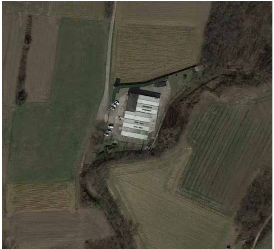
Area produttiva adiacente al corso del Lura a Rovello Porro
