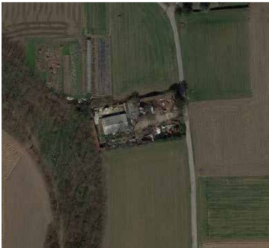
Deposito recintato fra la valle del Lura e il percorso ciclabile a Rovellasca
