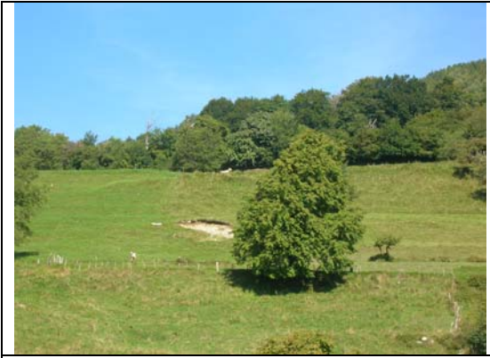
Foto 2: Frana in località Canelva
