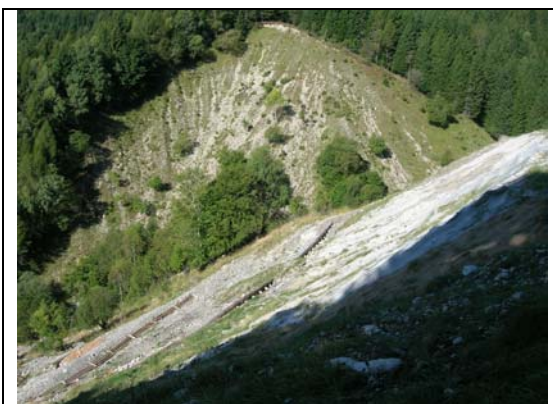
Foto 1: Frana in località Alpe di Sala
