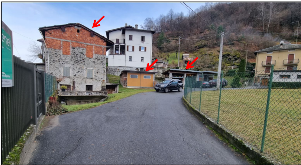
Foto 3.2: il fabbricato (mappale n° 58 del Foglio n° 1) e i garages (mappale n° 58 del Foglio n° 1) allagabili dalla piena dell'Adda con tempi di ritorno bicentenari a livello del pianterreno e con tiranti idrici di altezza inferiore a mezzo metro (freccie rosse)
