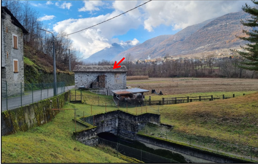
Foto 3.1: il fabbricato rurale distinto nel mappale n° 44 del Foglio 1 allagabile dalla piena bicentenaria a livello del pianterreno
