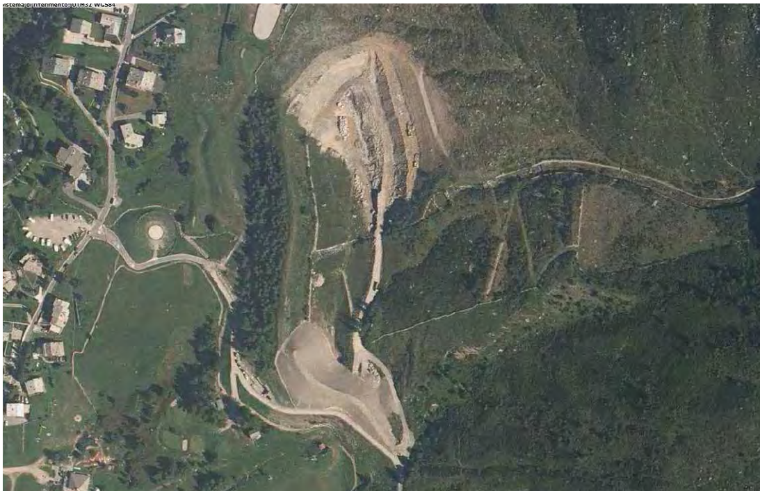
Foto 4: Estratto ortofoto geoportale con intervento realizzato per il 90% (manca inerbimento scarpate)
