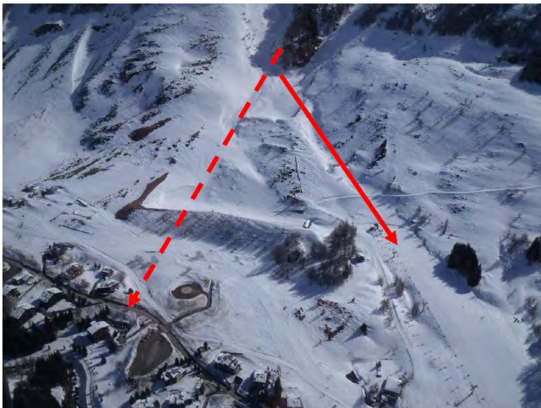
Foto 3: Panoramica invernale zona di arresto della valanga del Monte Mater prima del potenziamento del rilevato
