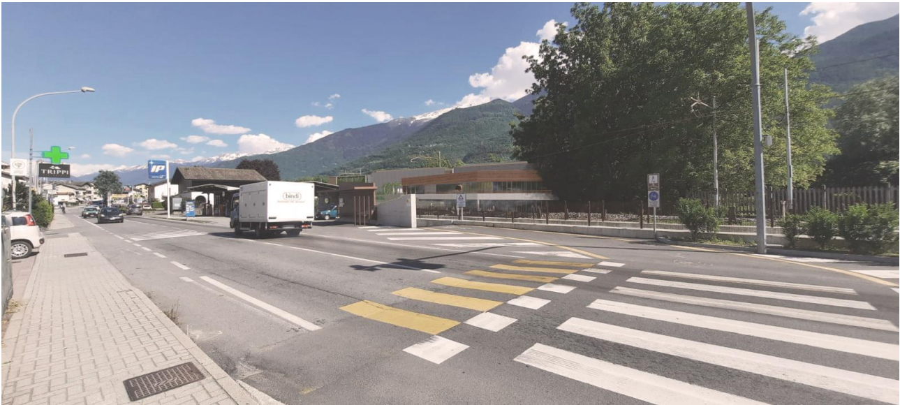
Figura 7 Vista frontale ingresso uffici
