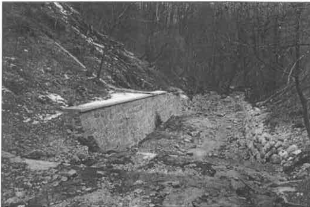
Foto 10: Interventi di difesa spondale lungo l'alveo del torrente Maladiga
