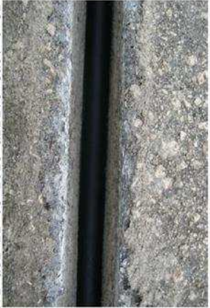
Scavo aperto con tubazione posata
