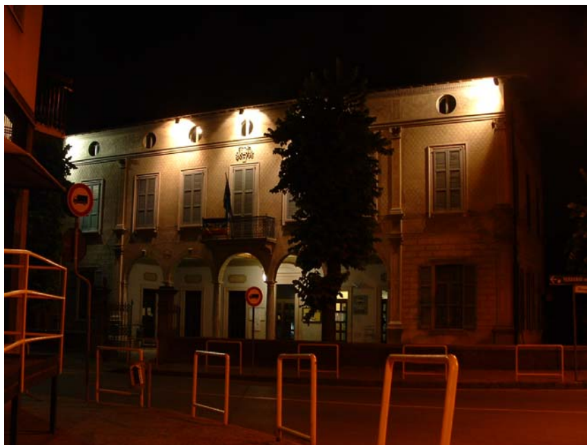
Municipio: la facciata è illuminata con proiettori installati in posizione sottogronda
