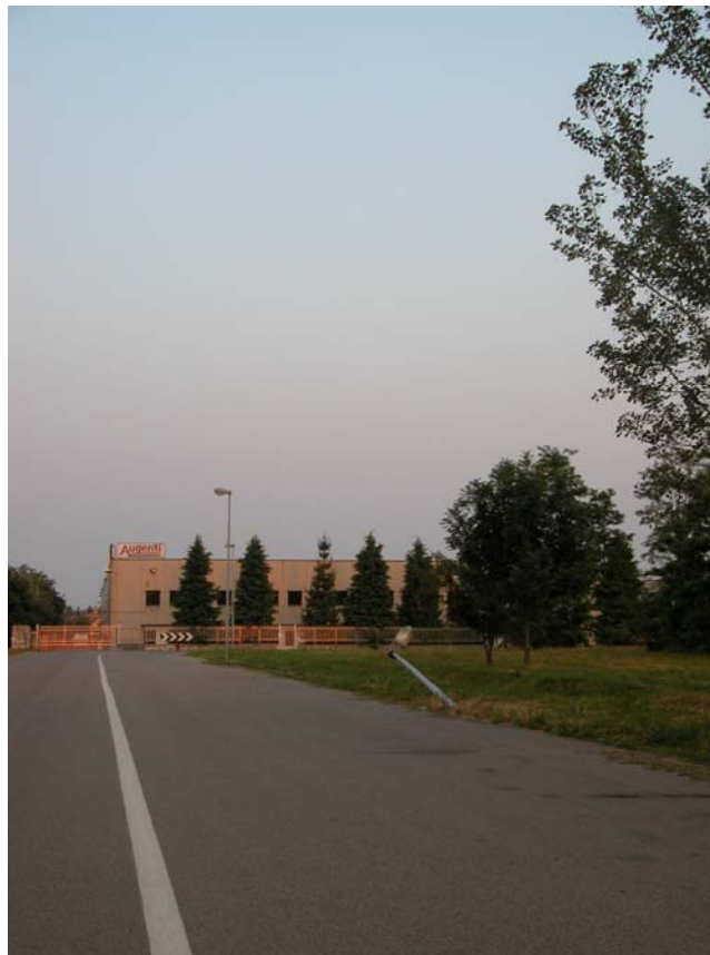
Apparecchi a coppa prismatica installati in zona industriale
