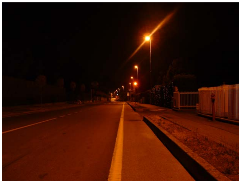
Via Sernovella: apparecchi equipaggiati con sorgenti al sodio ad alta pressione
