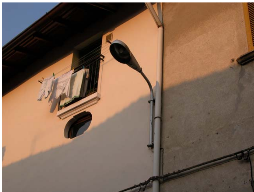
Via Fontanile: armatura stradale aperta
