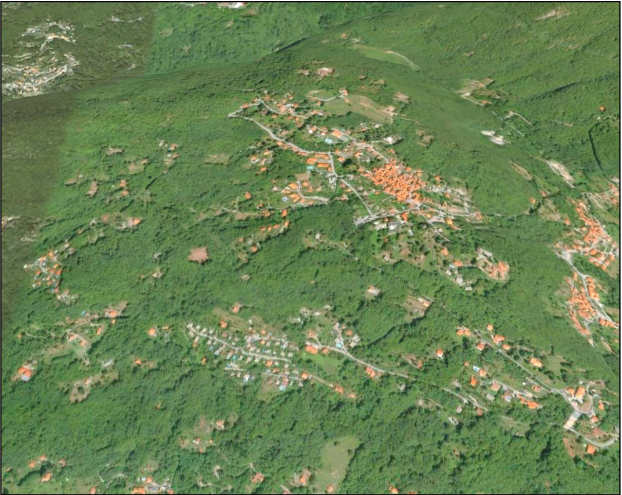
Vista aerea con ripresa da sud
