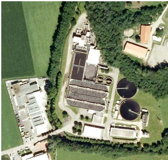
FIGURA 14: DEPURATORE CONSORTILE IN COMUNE DI BULGAROGRASSO
