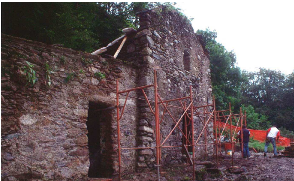
Lavori di ristrutturazione all'Alpe Ranciolo (estate 2011)
