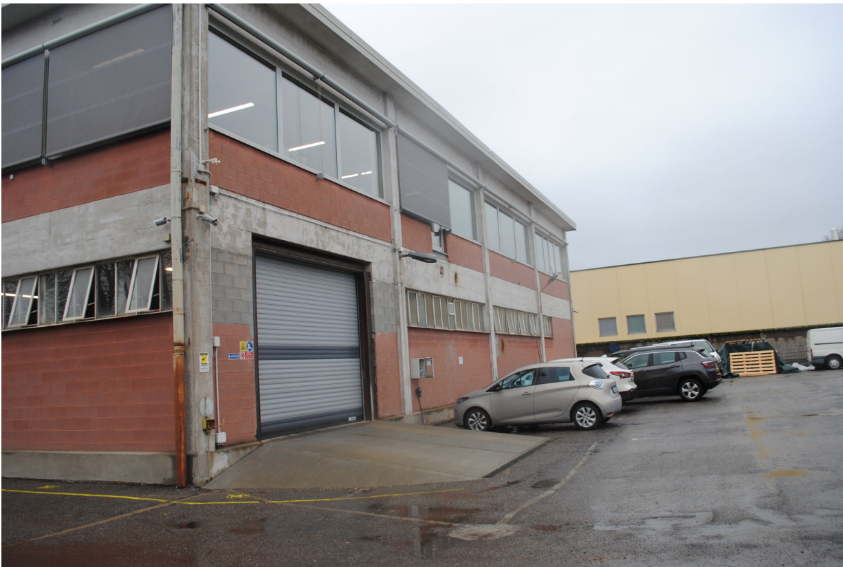
foto 6 Fabbricato 22 scala di sicurezza
