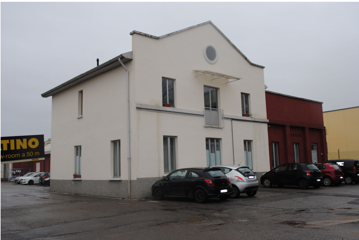
foto 2 Fabbricato 4c ampliamento
