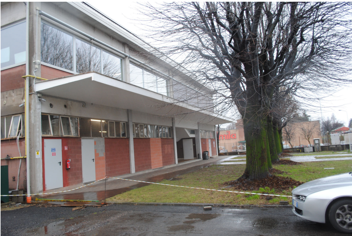
foto 4 Fabbricato 21 chiusura porticato
