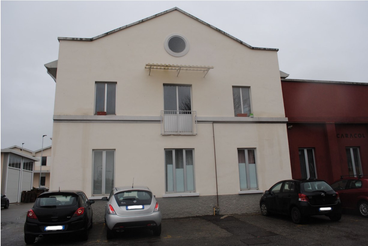
foto 1 Fabbricato 4c ampliamento
