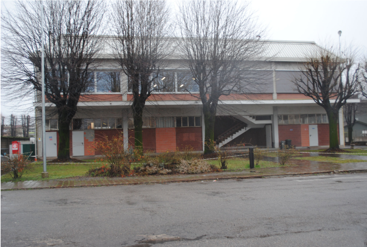
foto 5 Fabbricato 21 chiusura porticato
