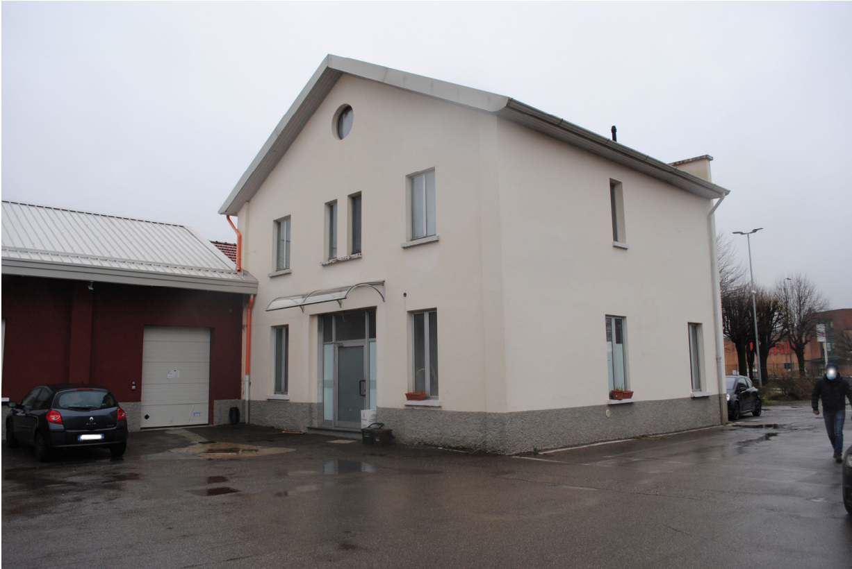
foto 3 Fabbricato 4c ampliamento
