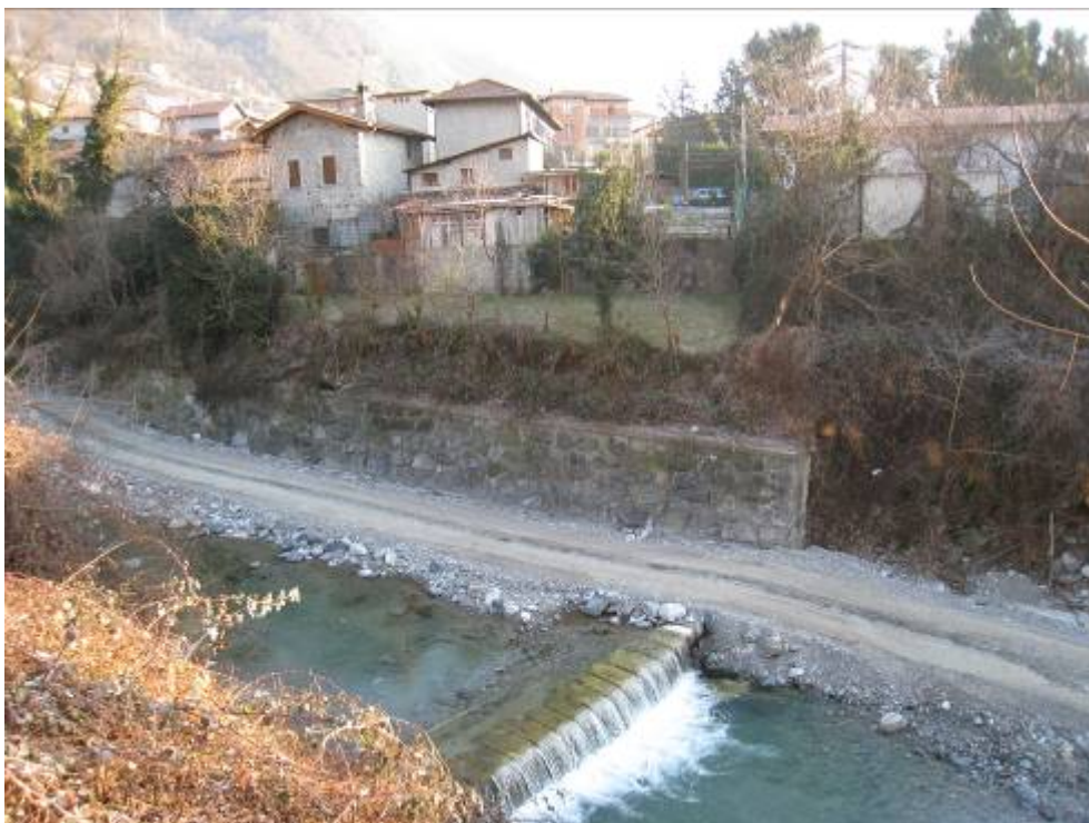
Soglia esistente lungo l'alveo
