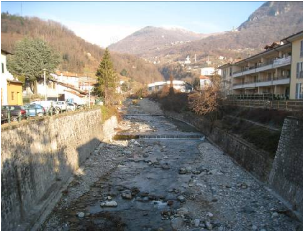
Vista verso monte dal ponte della S.S.Regina
