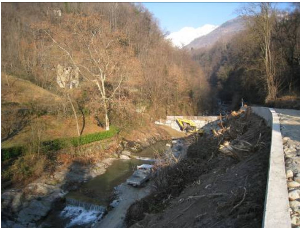
Briglia selettiva in fase di realizzazione (foto scattata nel gennaio 2010)
