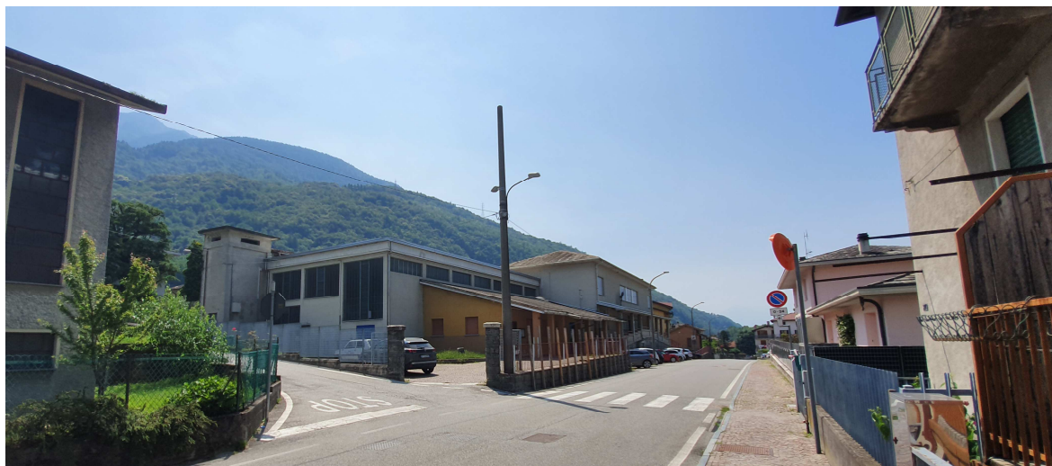
Vista del fabbricato con la rete aerea di illuminazione pubblica
