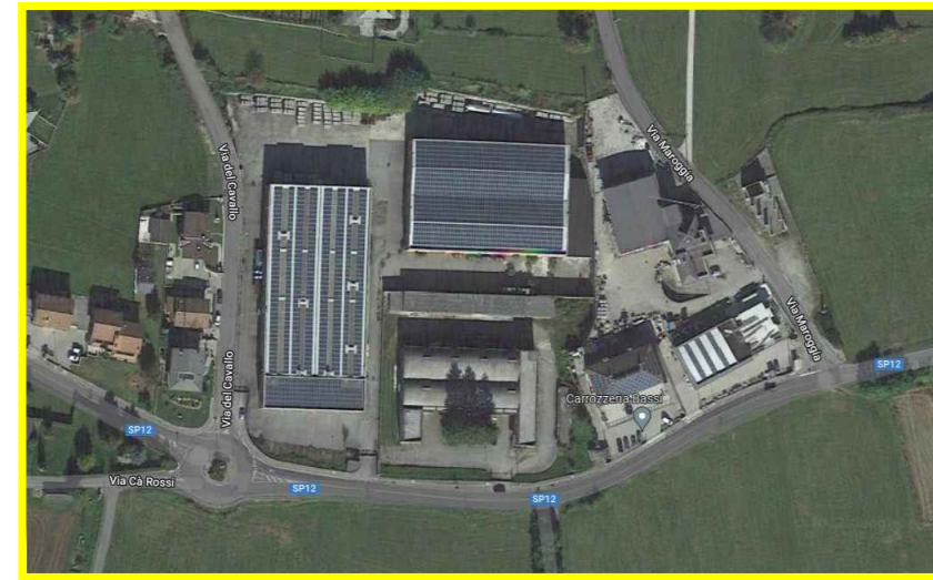
Discarica 1 - Cossi Costruzioni
