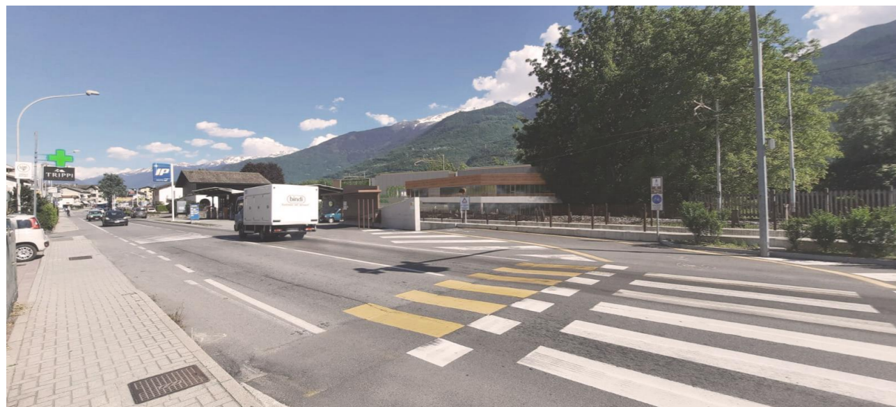
Figura 16. Vista frontale ingresso uffici
