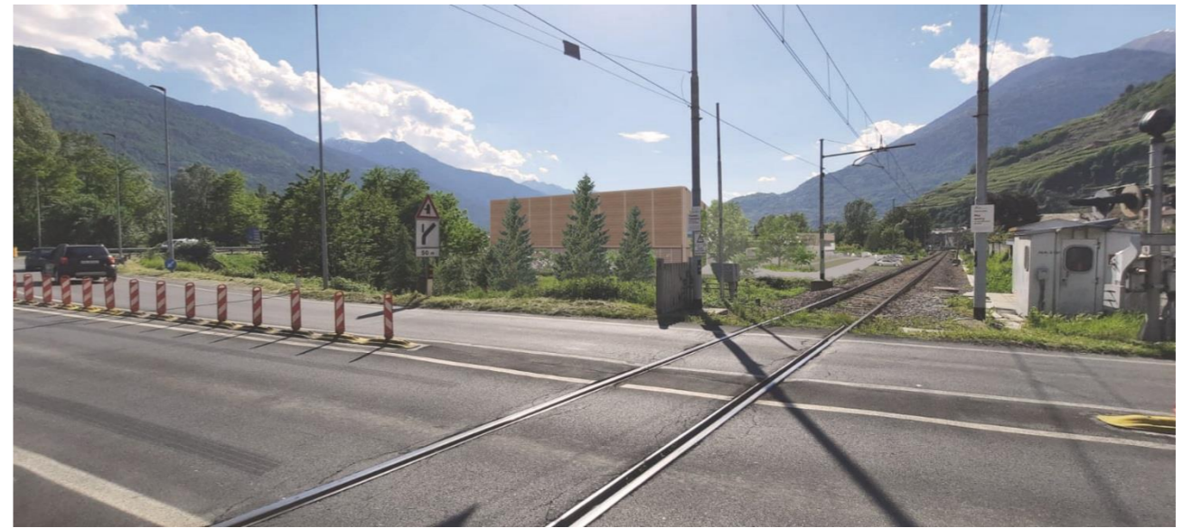
VISTA EST DALLA STRADA STATALE 38
