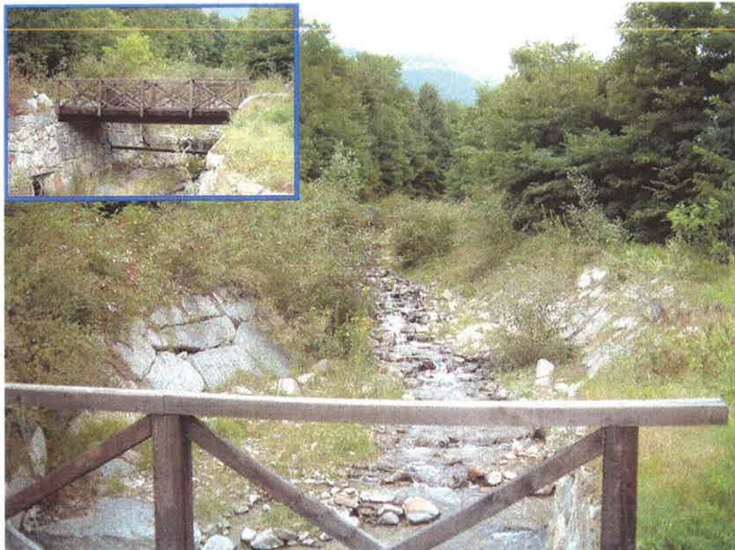
Foto 4 Visione verso monte dal ponte di quota 428 m slm (nel riquadro); conoide mediana.
