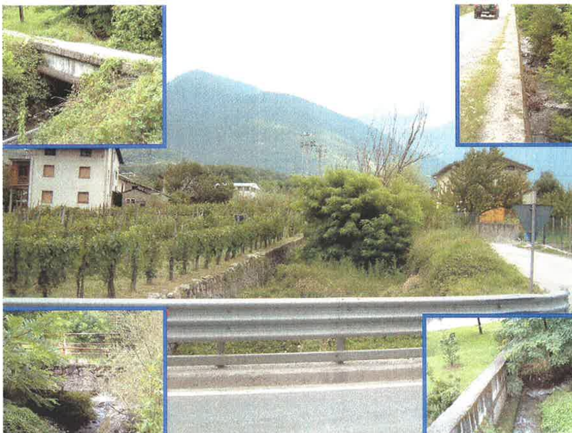
Foto 5 Zona distale della conoide; nei riquadri di sx, due ponti a quota 380 m slm con pochissima luce; in quelli a dx, l'argine sinistro del canale sopra (in alto) e sotto (in basso) il ponte a quota 347 m slm (ss 38).
