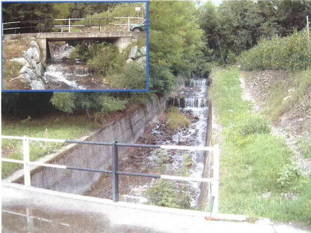
Foto 3 Visione verso monte dal ponte di quota 490 m slm (nel riquadro); conoide mediana.
