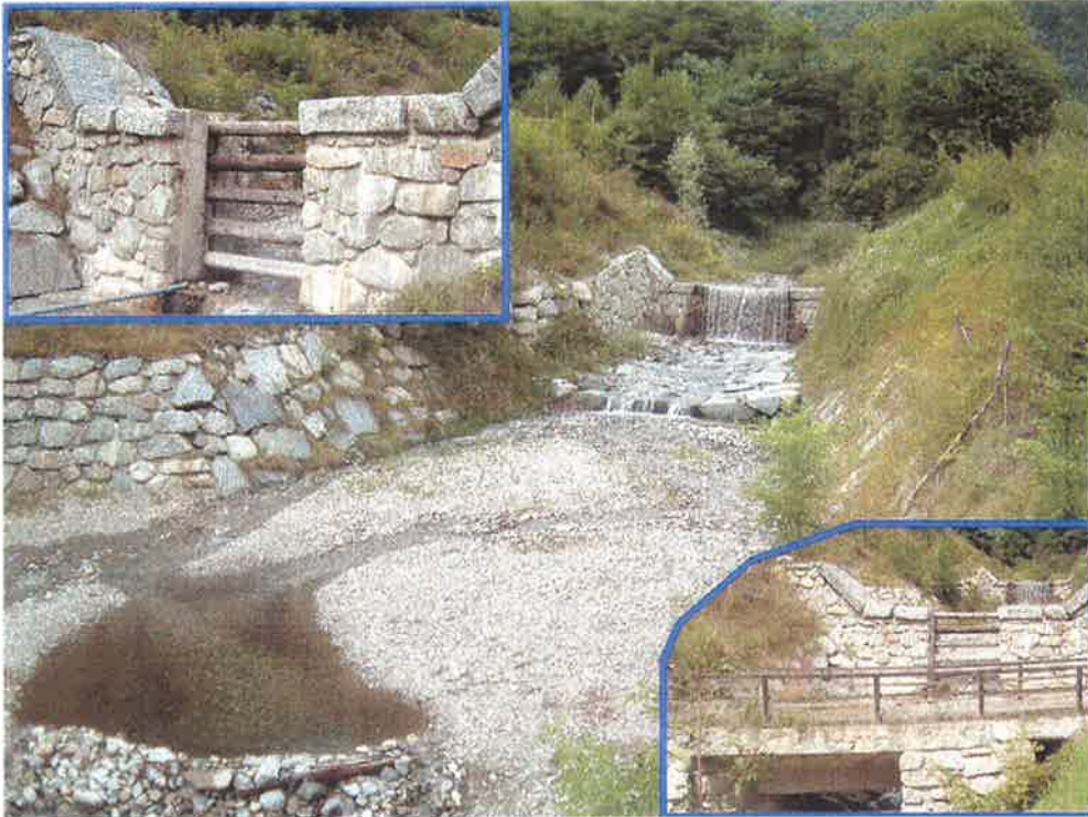
Foto 1 Vasca di espansione nella zona apicale della conoide (583 m slm); nel riquadro in alto a sx, un particolare della briglia; in quello in basso a dx, la vasca vista da sotto il ponte di quota 582,8.
