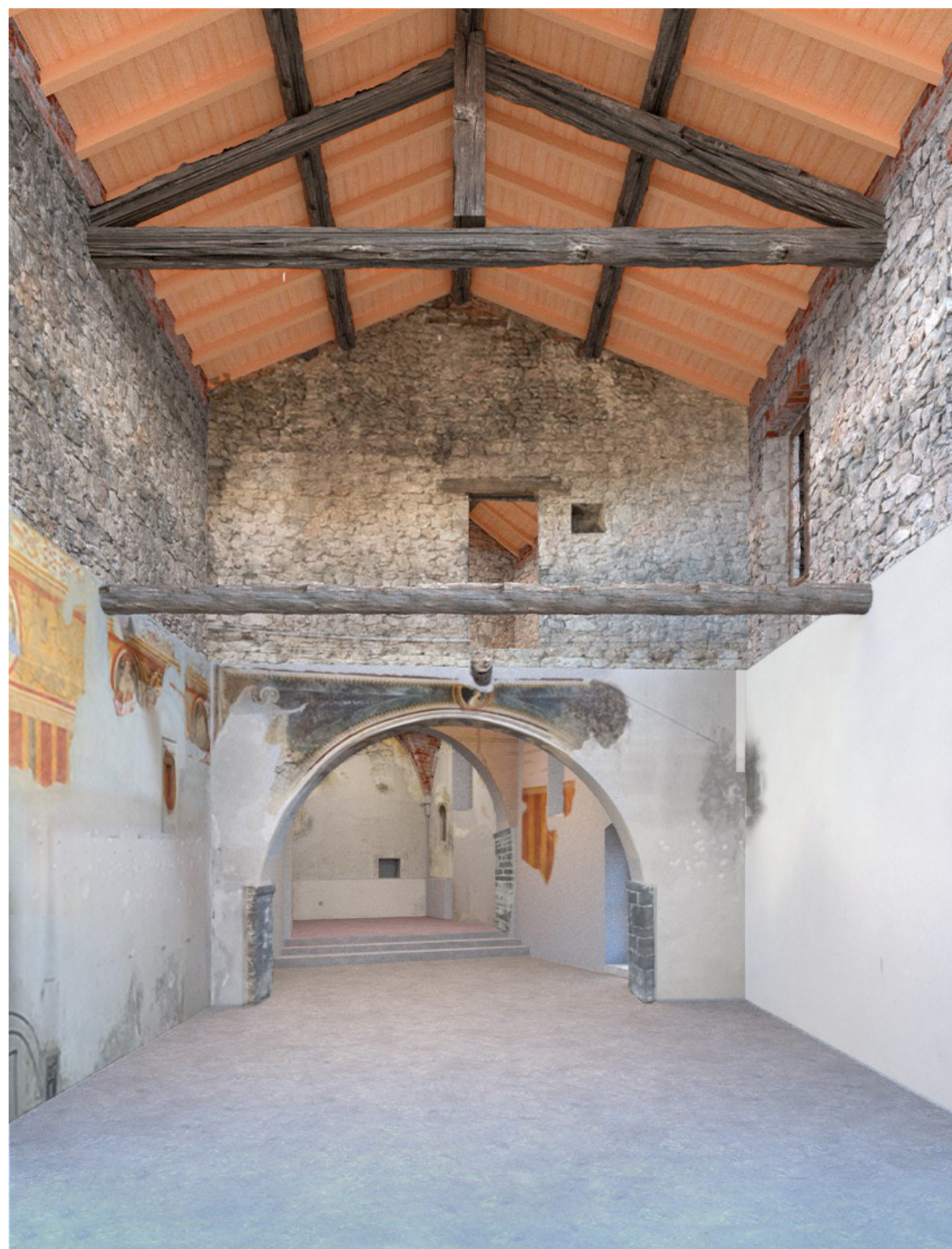
Vista dall'ingresso principale - STATO DI FATTO
