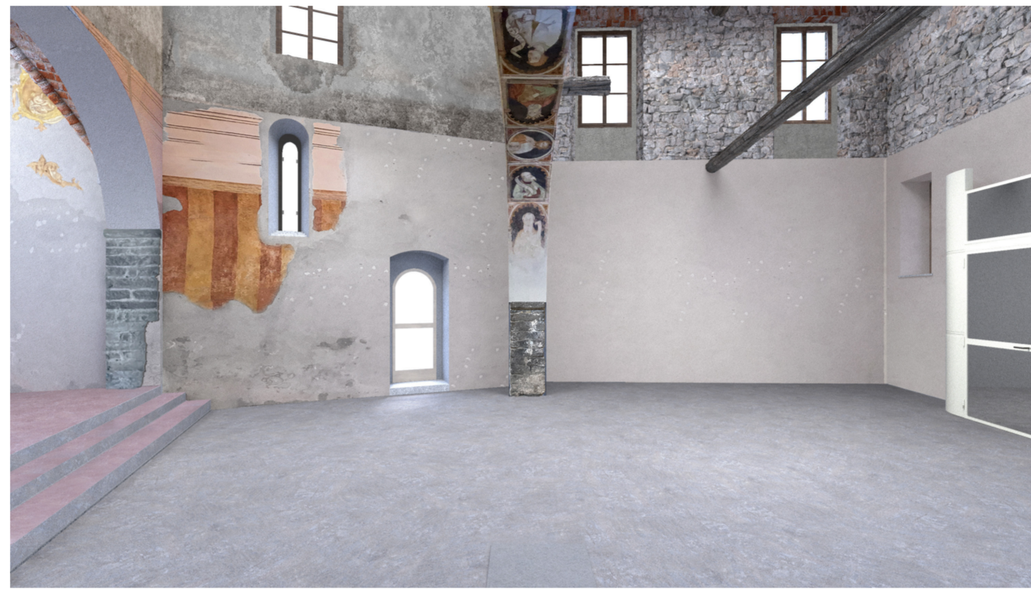
Vista tra la prima e la seconda campata verso l'ingresso secondario - STATO DI FATTO
