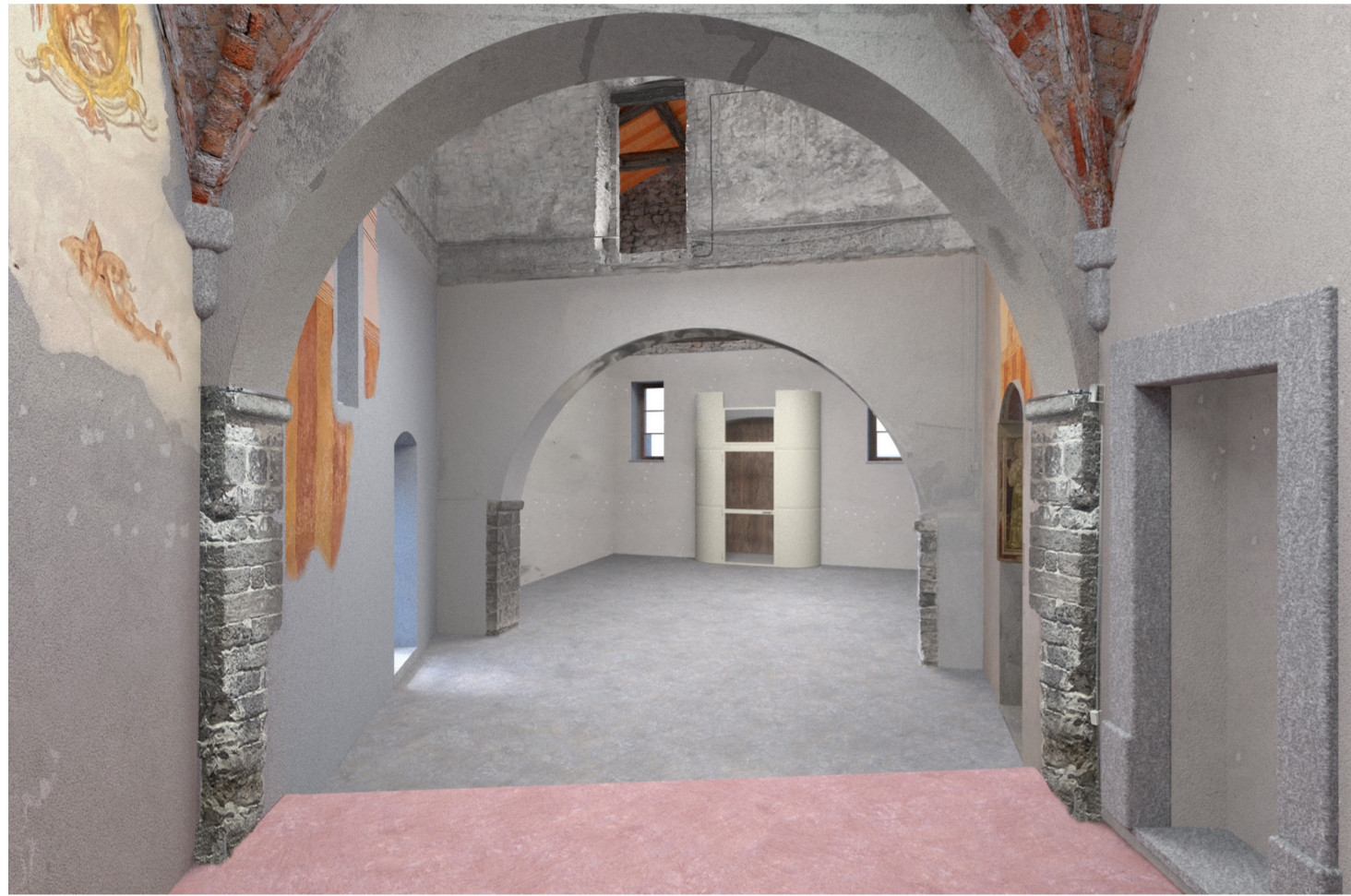
Vista dall'altare verso l'ingresso - STATO DI FATTO
