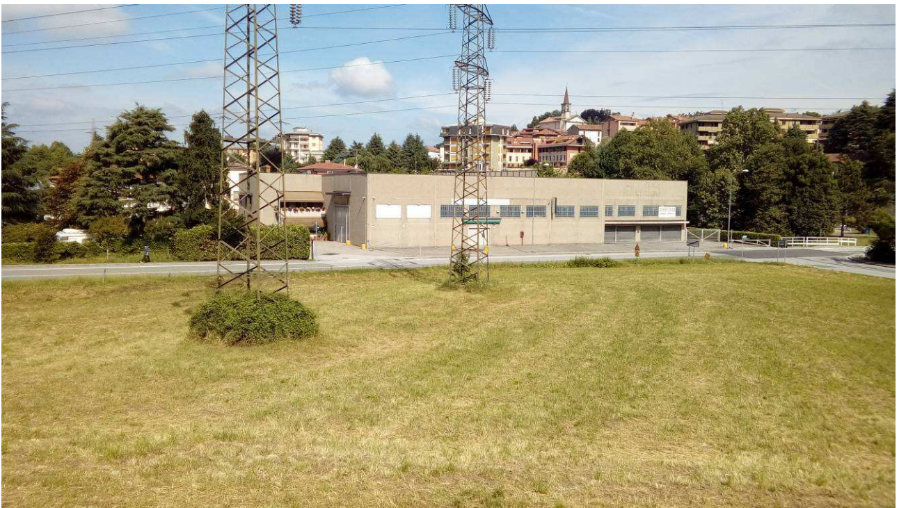
Foto 2: Area in oggetto vista da SE
