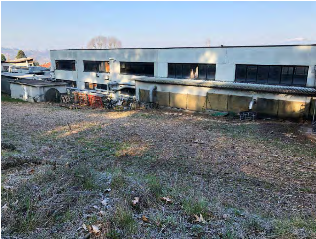
Foto n. 1: Zona ampliamento opificio principale
