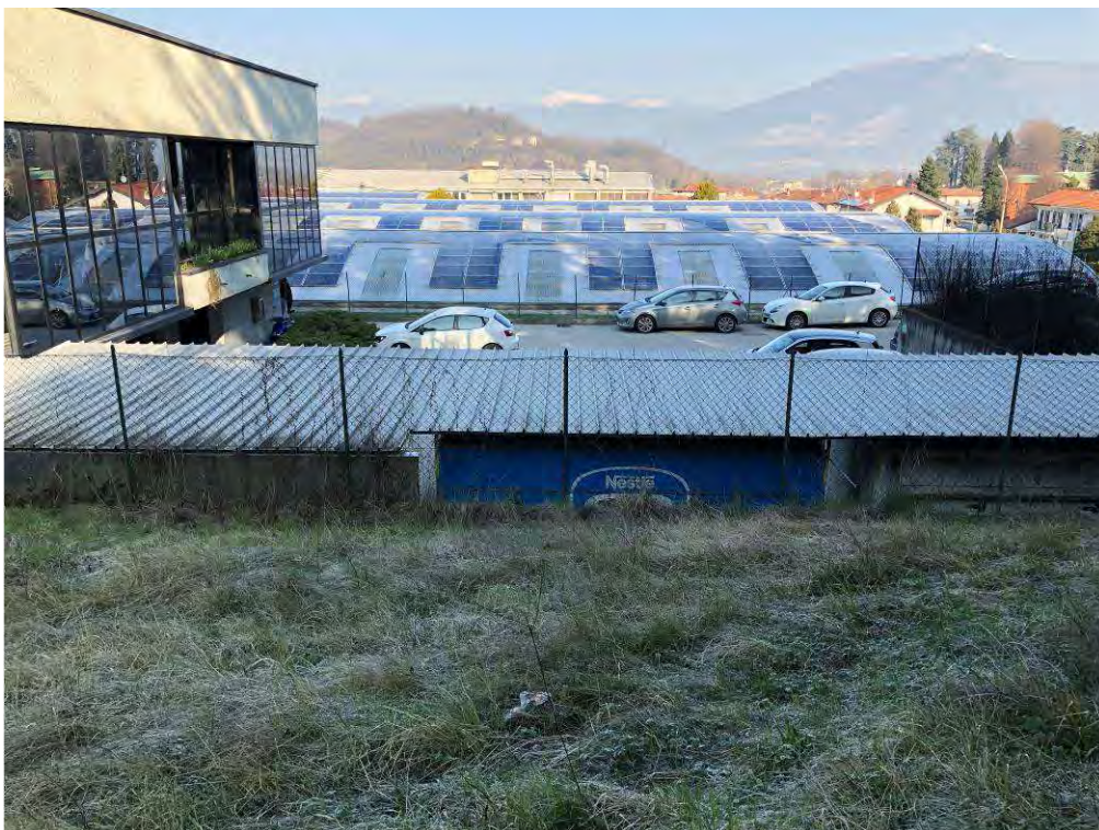
Foto n. 2: Zona ampliamento Uffici e Spogliatoi
