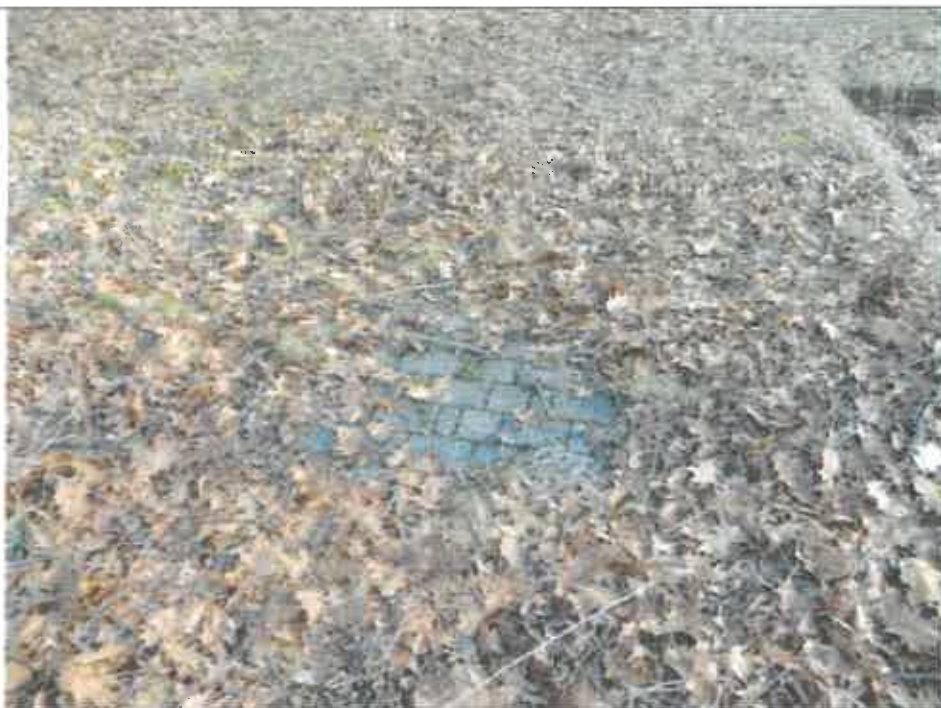
Fotografia 7: Stato di abbandono dell'area.
