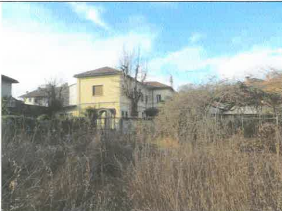
Fotografia 6: Stato di abbandono dell'area
