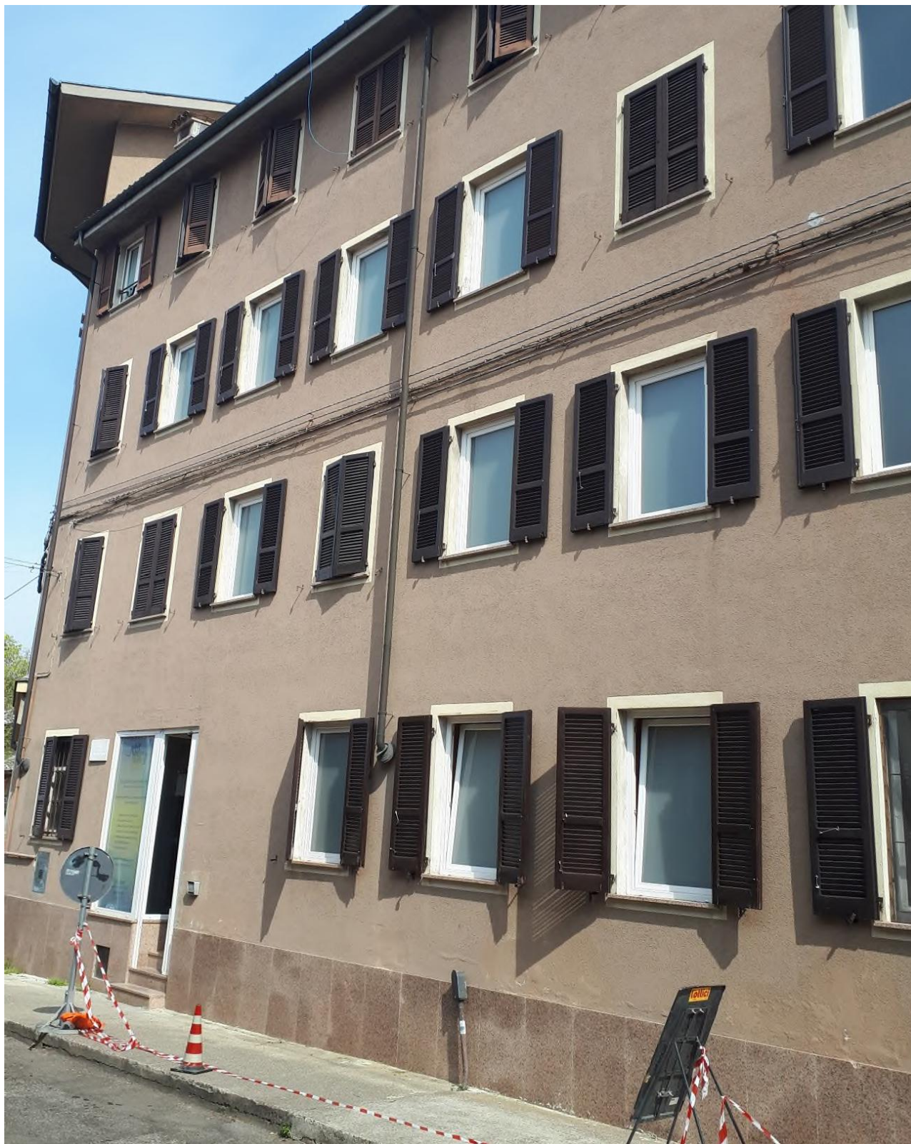
Figura 12 Esempio di tesatura di cavo precordato su tratto rettilineo
