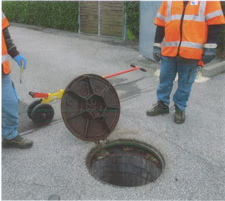
1 ISPEZIONE FOGNATURA COMUNALE ESISTENTE
