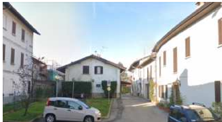
Figura 12 – Carreggiata inadeguata – via Cascina Cà
