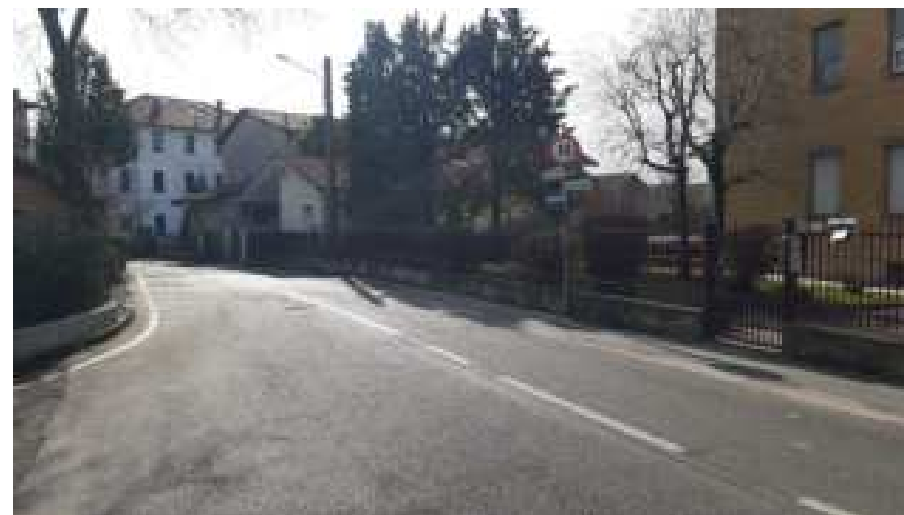
Figura 6 – Zona 10 in via Trento
